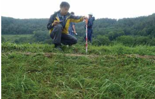
上流側痕跡は天端高-15cm程度
