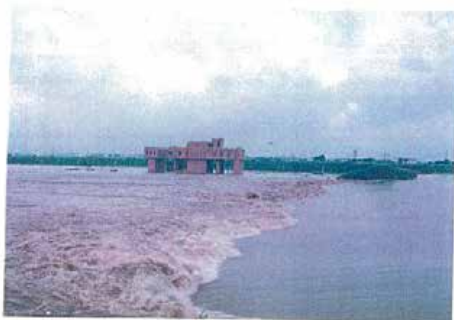
写真2.7.1(2) 流入堤流入状況 アスファルトフェーシング被災状況
