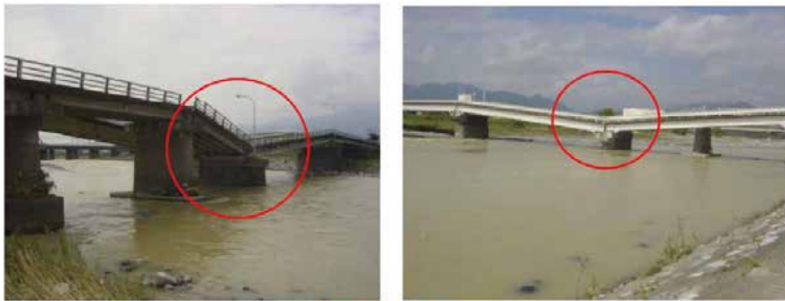
橋脚の洗掘・沈下
