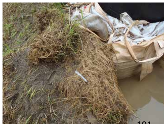
根毛層により越流水の侵食に耐えた
