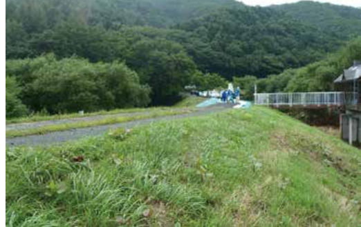
堤防天端高が下がっている区間で越水発生
