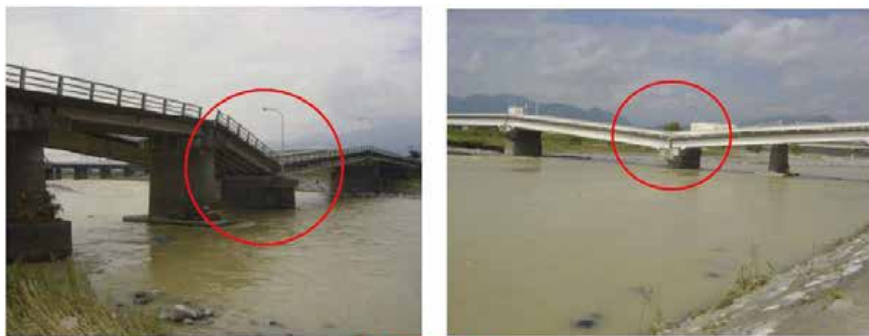
橋脚の洗掘・沈下
