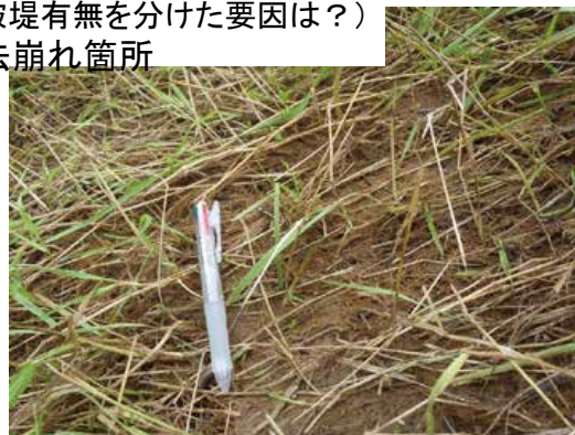
根毛層により越流水の侵食に耐えた
