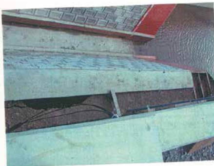
3cm沈下状況 (実験後10日 後)全景
