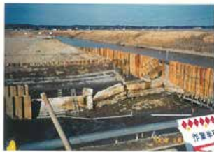
樋管の開削状況
