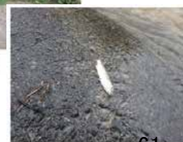
漏水箇所付近の状況
