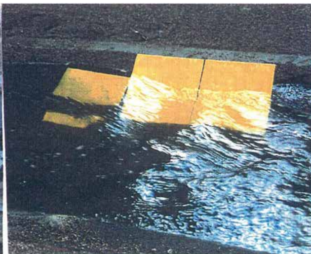
写真-6 施工端からの破壊状況 ケース2 (護岸模型2)
