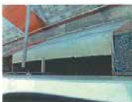
浮上10cm天端状況
