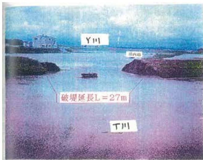
破堤状況(破堤直後 14日AM11:00)
