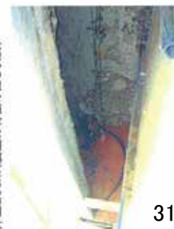
浮上20cm(基込め材抜け出し状況)
