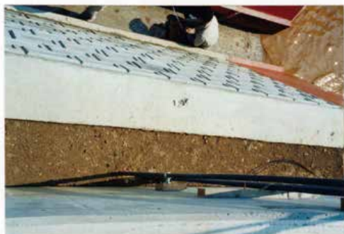
通水10分後 ケース1(浮上がり3cm)
