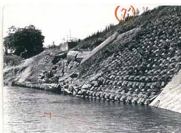
写真-2 間知ブロック積み護岸(胴込めが不足している場合)の被災
