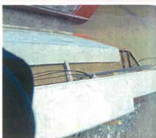
通水170分後 浮上3cm天端状況
