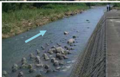
根固め工の設置状況
