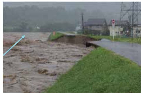
④浸透破壊による堤防の決壊
