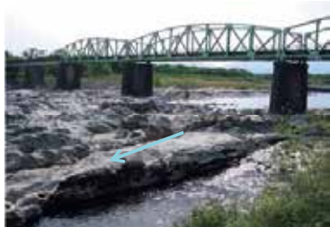
更新統の露出した状況 (洪積層)
