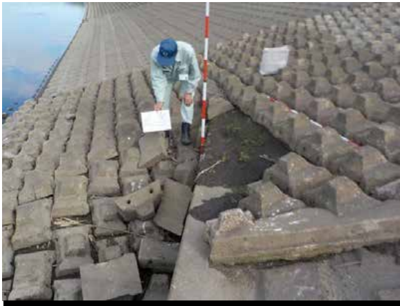
A河川：⑬護岸の破損 c評価
