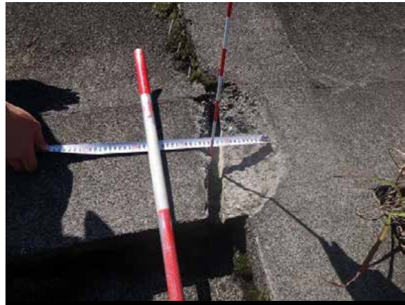
B河川：⑬護岸の破損 c評価
